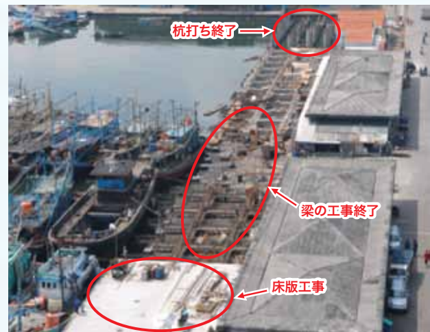
岸壁工事の手順が分かる写真
