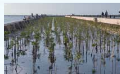
左が既設の西防波堤、右が新設の岸壁。その間に土を入れ、マングローブを植えた
