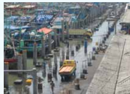
杭の打設が終わった岸壁、既設岸壁は冠水している。
