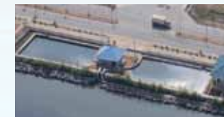
貯水池とポンプ所(中央)。雨が降ると雨水は池に入り、池の水位が所定の高さになるとポンプが作動し、排水する
