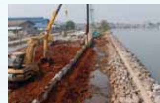
左は、西護岸の矢板の打設工事(右側の既設護岸は石を追加した)。右は矢板の頭部をコンクリートで保護し、完成した堤防
