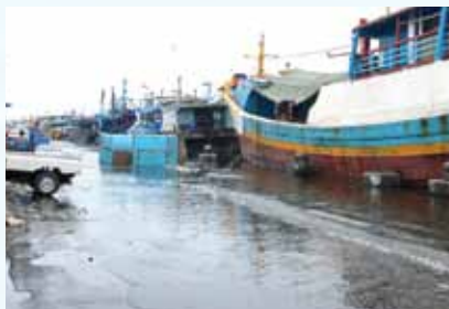
岸壁がしばしば冠水し、荷役作業に支障をきたしていた
