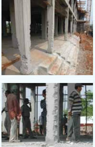
数人の男によりハンマーで大きく破壊されたムアラバルセンターの鉄筋コンクリートの柱。一部鉄筋がむき出しになっているのがわかる
