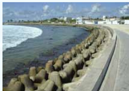
完成した東護岸
