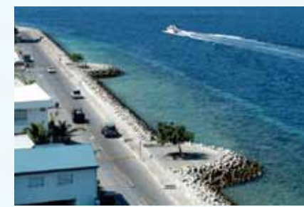
西護岸とテラス
