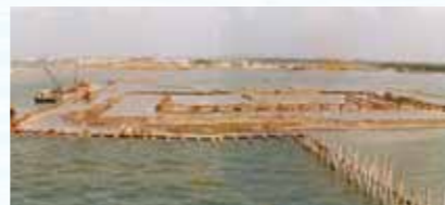
岸壁の杭工事、埋め立て工事当時の様子
