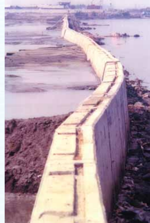
西護岸のすべりの様子。護岸が大きくゆがんでいるのがわかる
