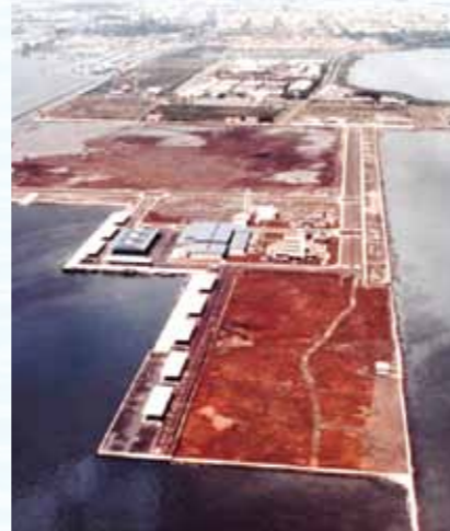
1984年、ジャカルタ漁港の2期工事が終了し、開港した
