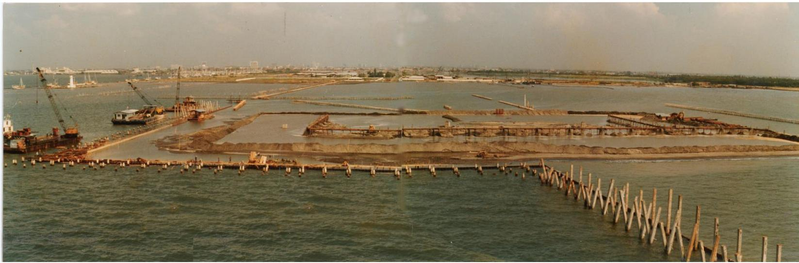
軟弱地盤での防波堤・護岸(4000m)建設にインドネシアでの伝統的工法の竹杭・竹マットが採用され、豊富な労働力および現地材料の竹100万本が使用された。
