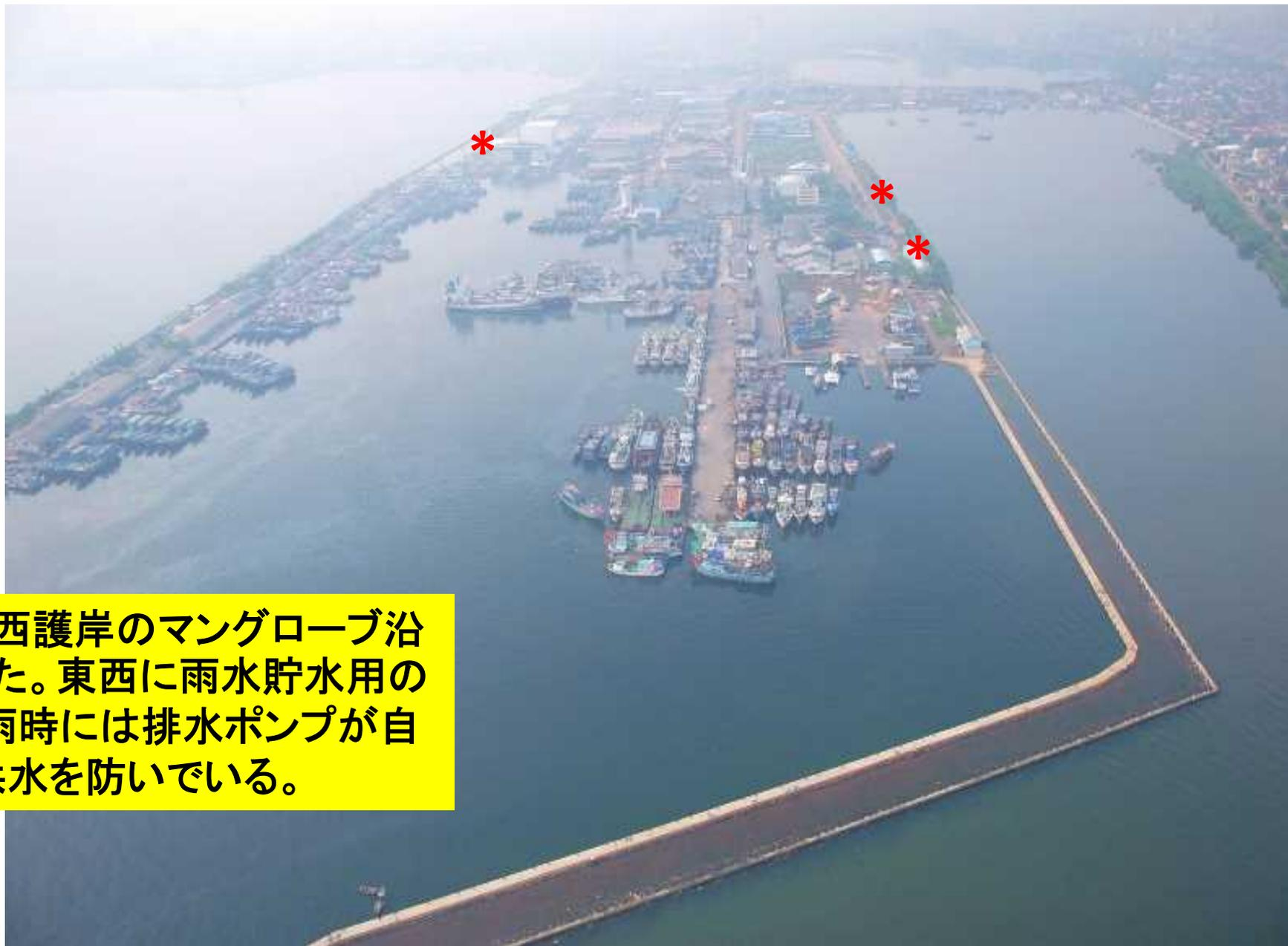
リハビリ事業完成。西護岸のマングローブ沿いに堤防\*を強化した。東西に雨水貯水用の池\*を新設して、降雨時には排水ポンプが自動作動し、港内の洪水を防いでいる。
