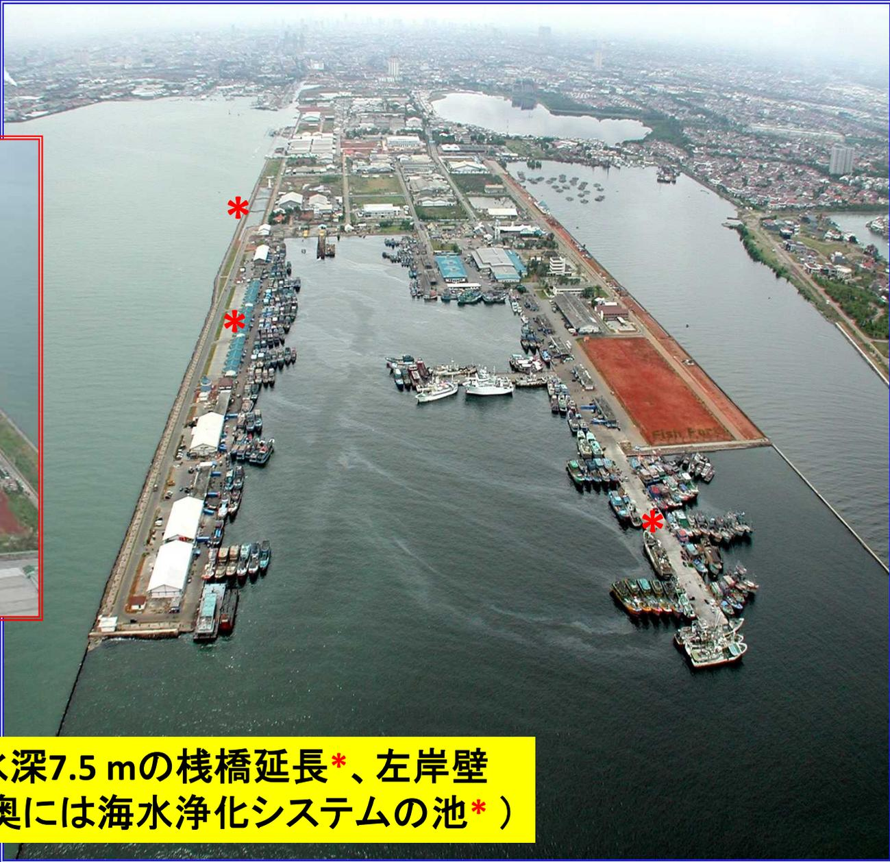
第4期工事完成後(手前右:200mの水深7.5 mの棧橋延長\*、左岸壁沿い:生マグロ荷捌き場\*の新設、左奥には海水浄化システムの池\*)
