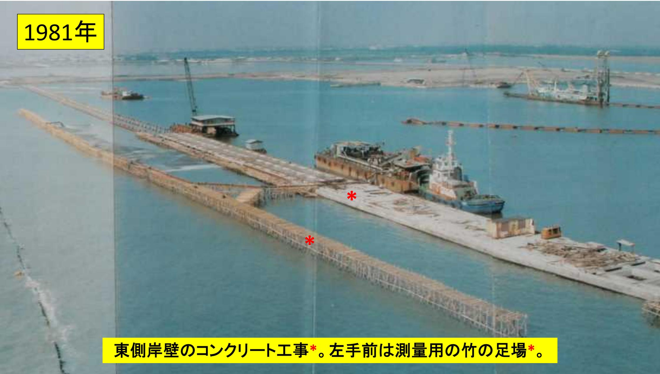
東側岸壁のコンクリート工事\*。左手前は測量用の竹の足場\*。
