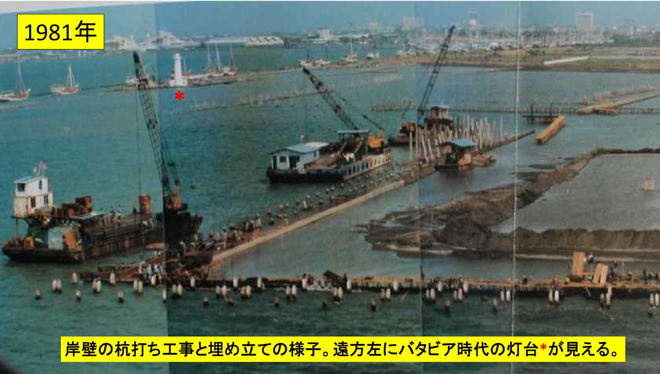
岸壁の杭打ち工事と埋め立ての様子。遠方左にバタビア時代の灯台\*が見える。
