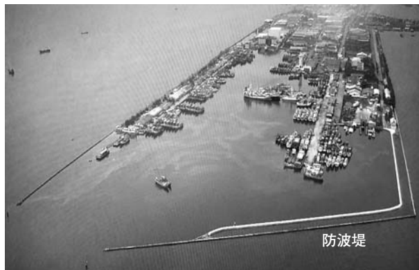
写真1 ジャカルタ漁港全景（2011年3月撮影）
