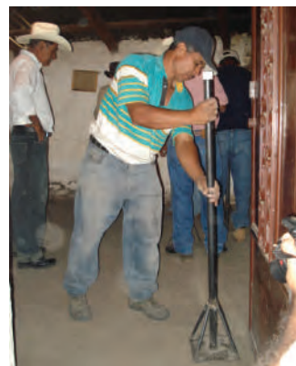
Pared revocada con la mezcla probada (izquierda) y acción de apisonamiento (derecha) en una vivienda de aldea La Brea, Quezada, Jutiapa, 2008.
