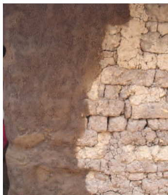
Pared revocada con la mezcla probada (izquierda) y acción de apisonamiento (derecha) en una vivienda de aldea La Brea, Quezada, Jutiapa, 2008.
