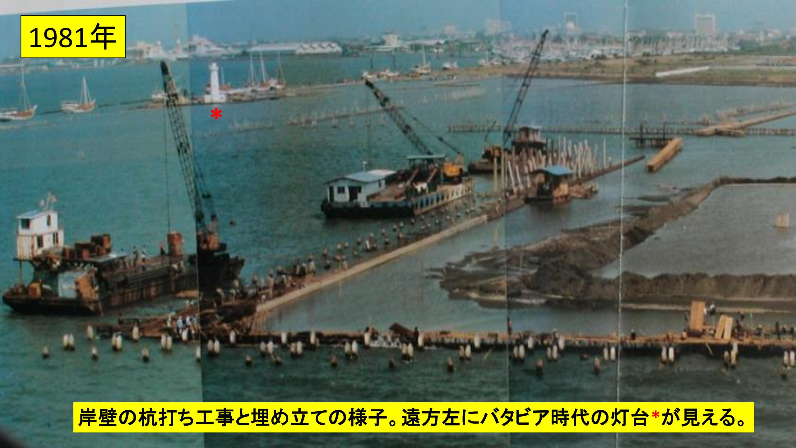
岸壁の杭打ち工事と埋め立ての様子。遠方左にバタビア時代の灯台\*が見える。
