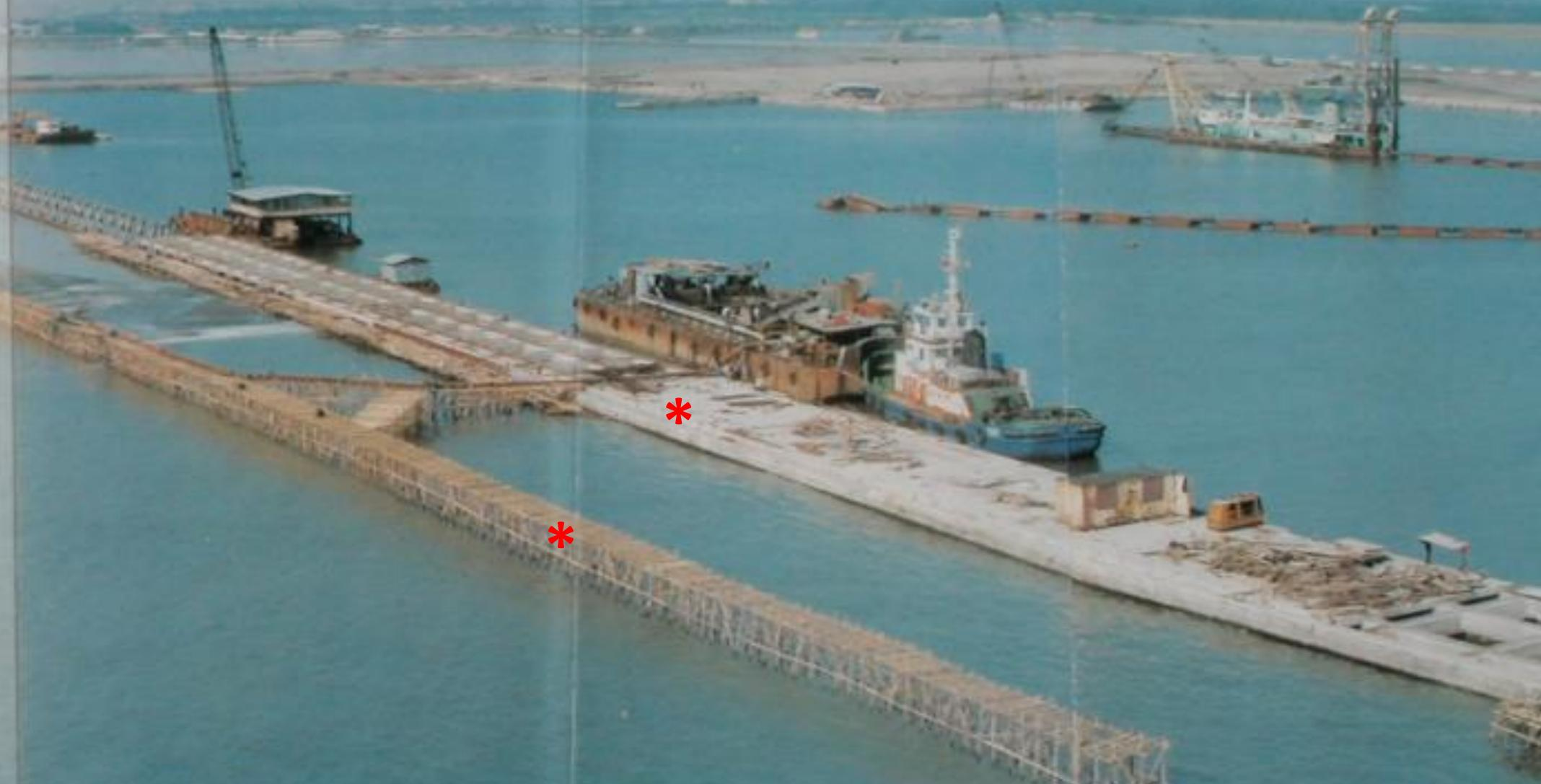
東側岸壁のコンクリート工事\*。左手前は測量用の竹の足場\*。
