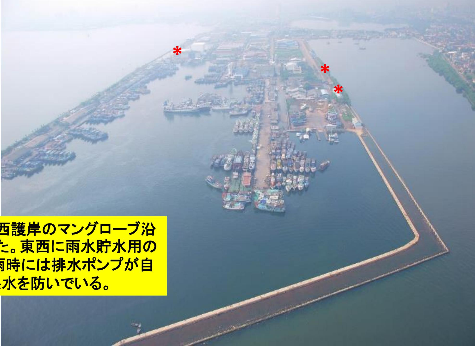
リハビリ事業完成。西護岸のマングローブ沿いに堤防\*を強化した。東西に雨水貯水用の池\*を新設して、降雨時には排水ポンプが自動動作動し、港内の洪水を防いでいる。
