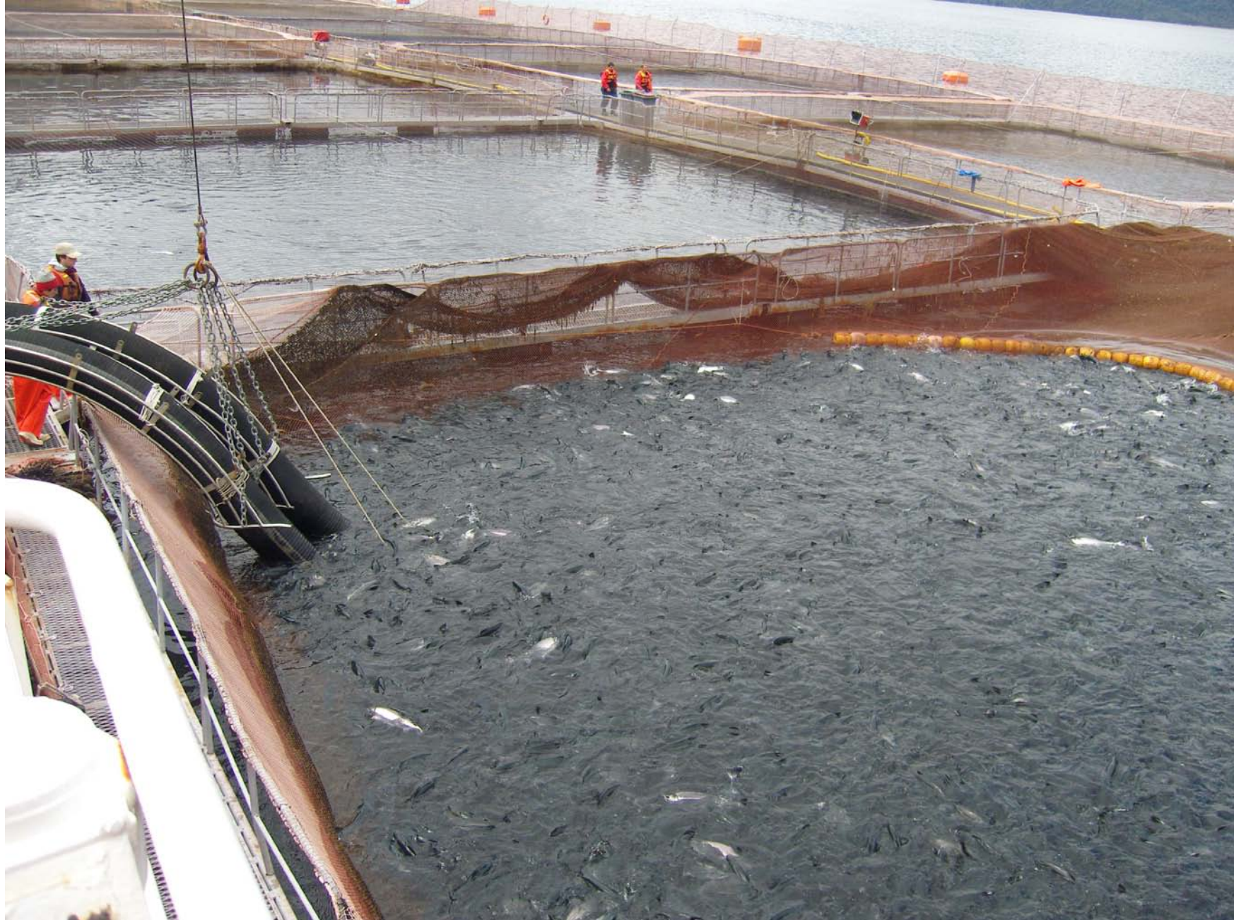
大型生簀からのサケを搬送する真空パイプ設置(2009年) 提供: アグロスーパー社(チリ)
