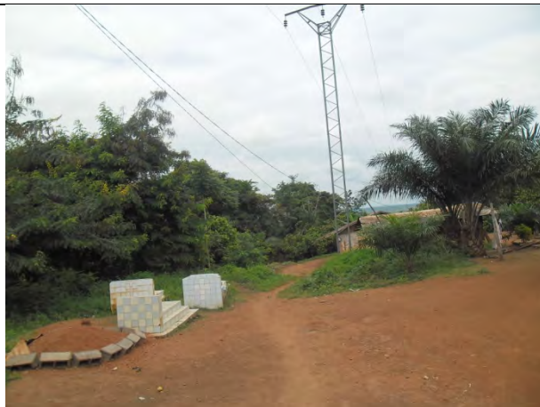
Cimetières et Poteau dans l'emprise de la route
